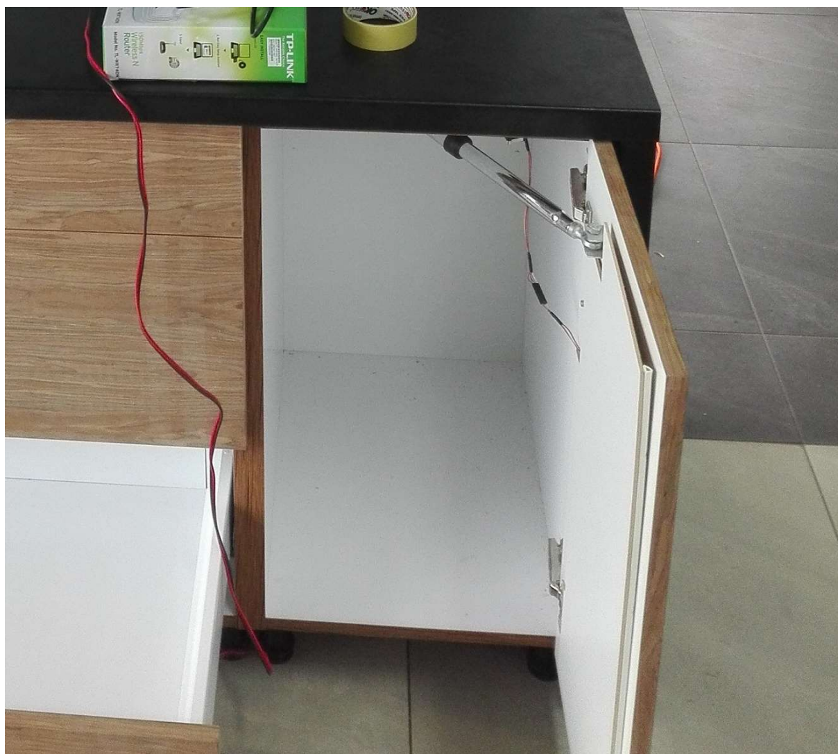
zdj 1. Mechanizm otwierania drzwi
